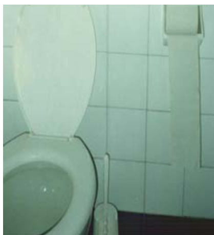
Uno dei problemi rilevati dai bambini
